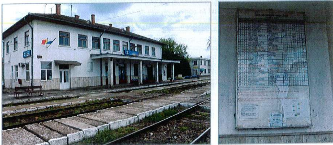
Figura 2.60. Stația de cale ferată Luduș - amenajări.
