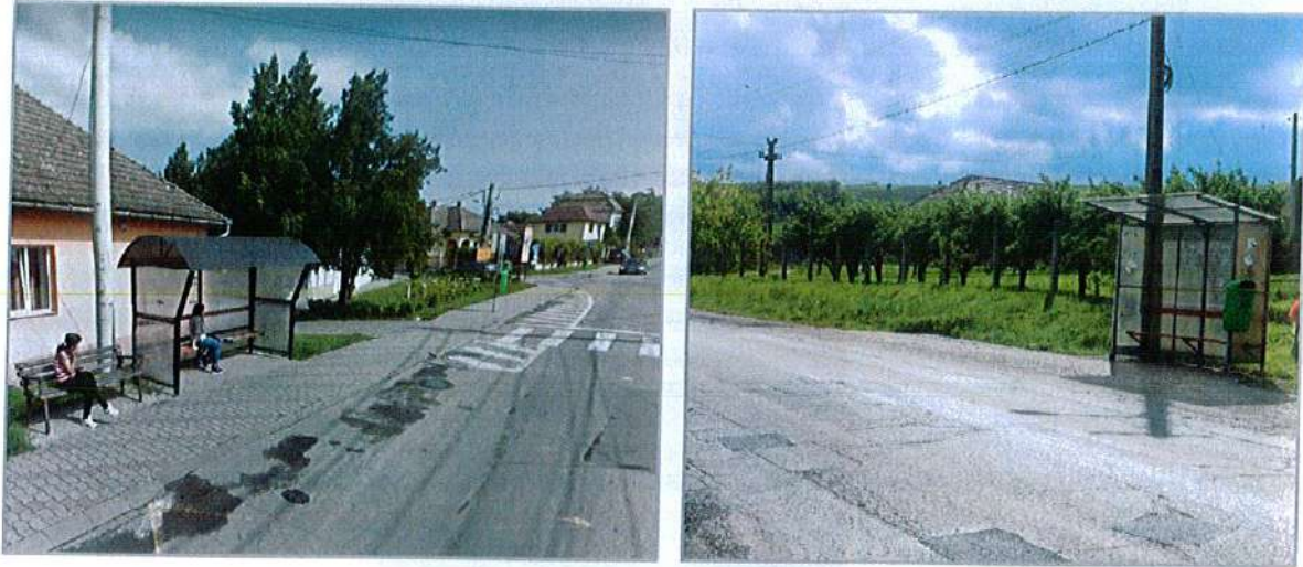
Figura 2.42. Stații de transport public cu adăpost pentru călători (exemplificare).
